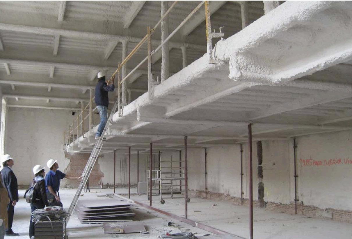
Fig. 9. Construcción del nuevo Gabinete Numismático (2009).
