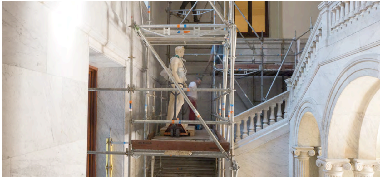
Fig. 10. Proceso de colocación de la escultura de Mercurio en la escalinata principal del MAN.
