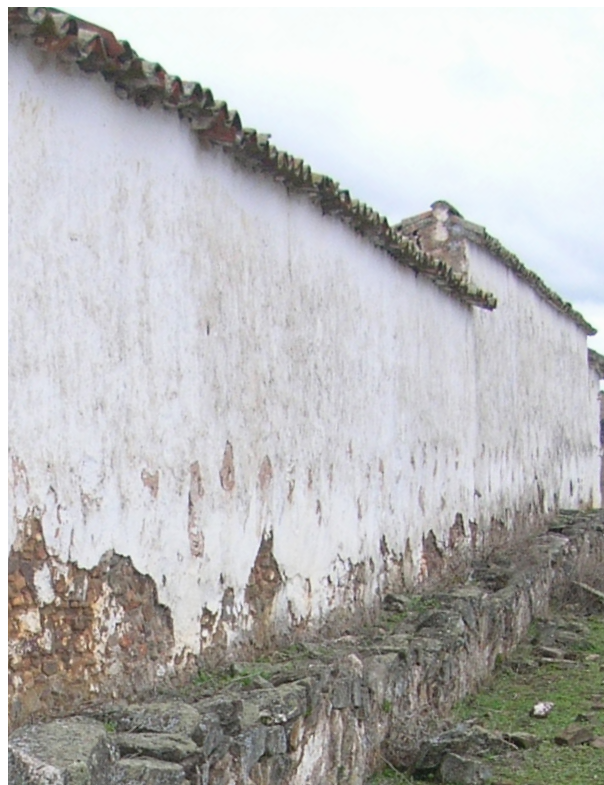
Fig. 10. Cortijo de Majadaiglesia, cuya cimentación aprovecha antiguas estructuras.
