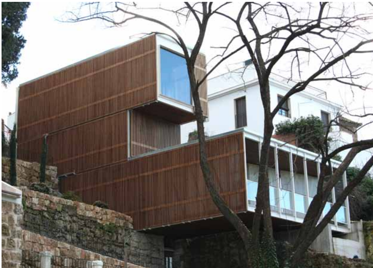
Fig. 5. Entrada a la futura nueva sede del Museo, realizada en 2012.
