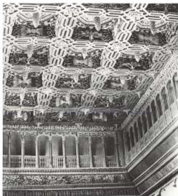
Fig. 1.—Artesonado de la sala nueva de la Aljafería.
