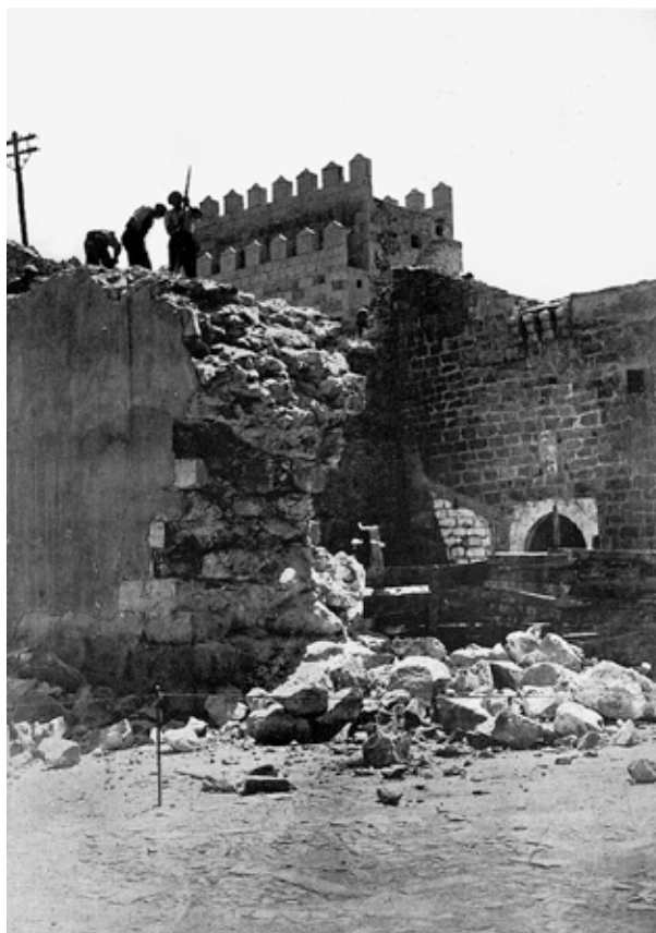
Fig. 4. Derribo del antiguo Alcázar. Foto: Díaz Casariego, 1930.
