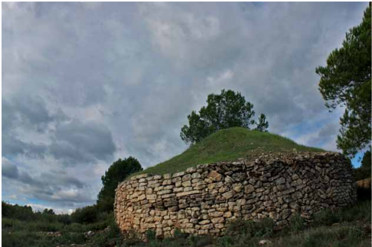
Fig. 4. Cuco Magna, construcción piedra en seco.
