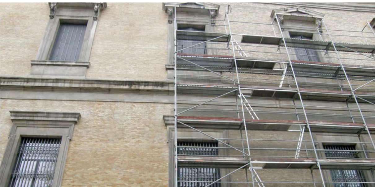
Fig. 7. Estado final y tratamiento mediante andamios en la zona sur.
