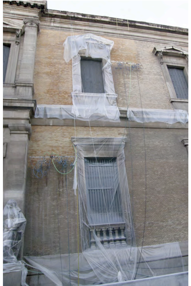
Fig. 5. Instalación de atomización descolgada.
