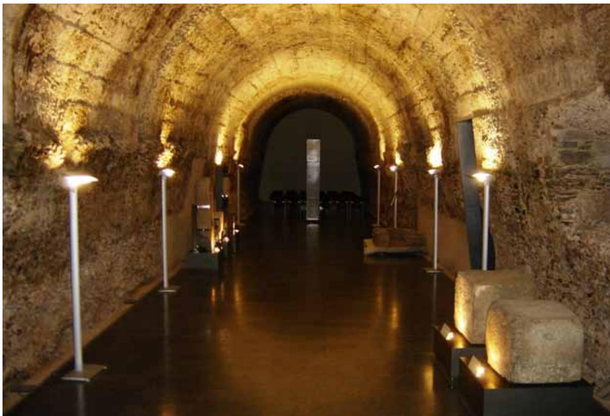
Fig. 1. Galería abovedada, conocida tradicionalmente como «La Ergástula Romana», sobre la que se construyó el edificio que alberga el Museo Romano de Astorga. Foto: M.ª Á. Sevillano.
