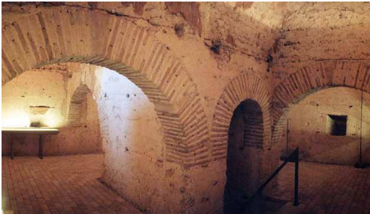
Fig. 1. Planta segunda: arcos de ladrillo e instalaciones museográficas.
